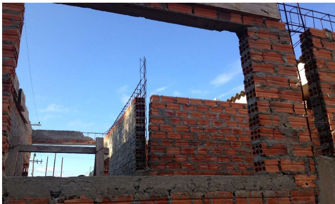
Figura 09: Cintamento armado inacabado.
