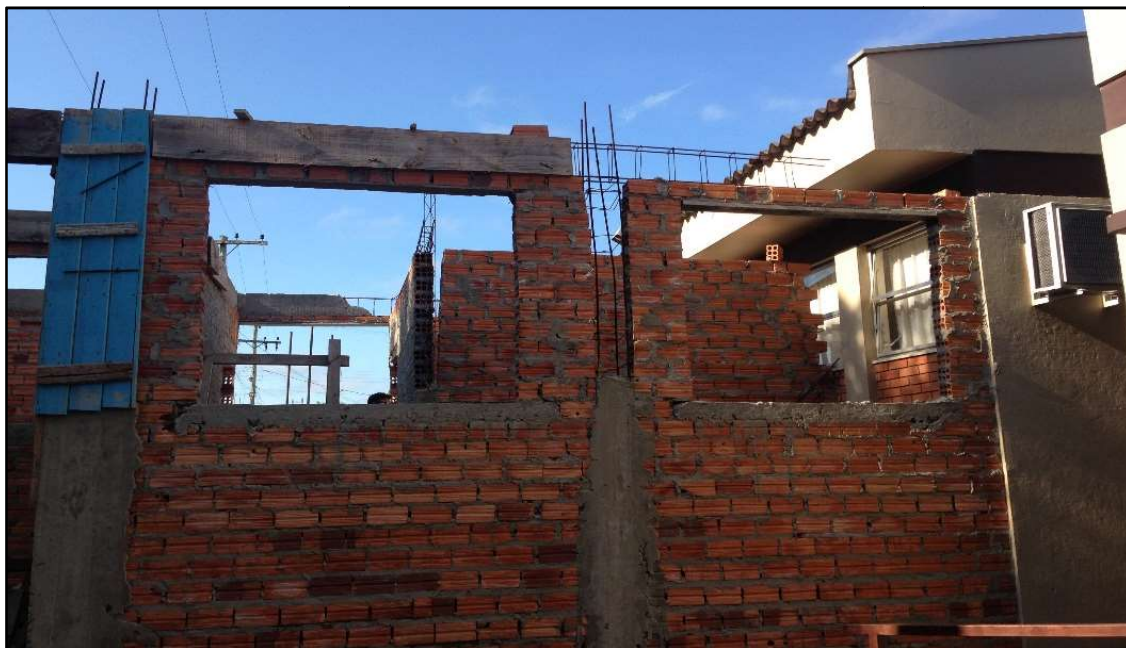
Figura 04: Vista externa fundos (cintamento armado sem concretagem),
